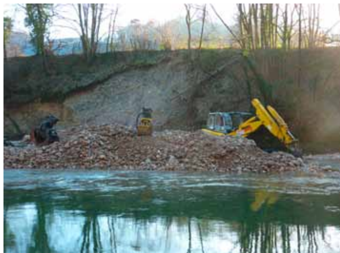
Aufwändige Bauarbeiten im Erosionsgebiet und in der Flussmitte
