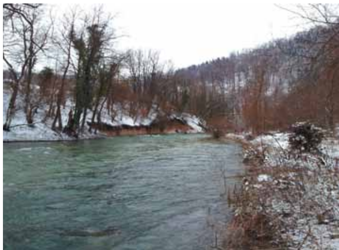
Gut sichtbare Erosion
