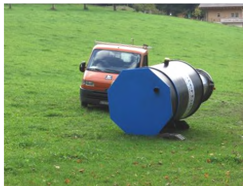
(Die neue Brunnstube vor und nach der Montage. So gross wie ein Lieferwagen).
